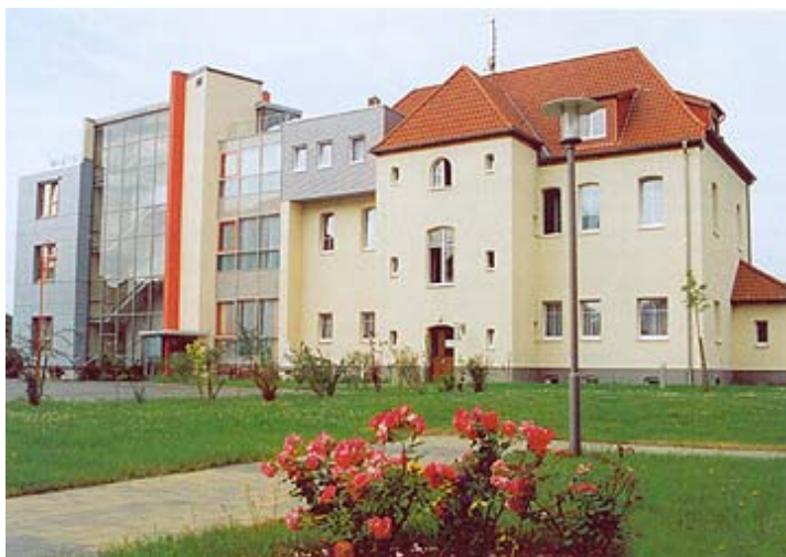
Haus 2 (sanierter Altbau mit neuem Anbau)
